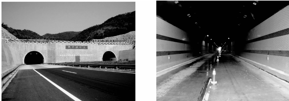
(a)隧道出入口
