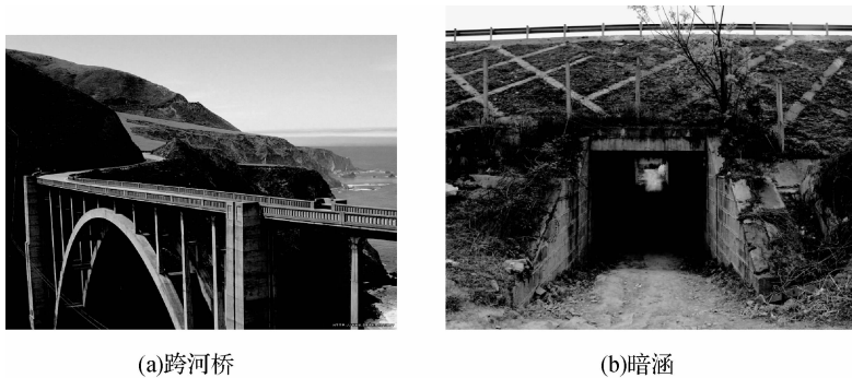
图 1-11 桥梁与涵洞实体图
