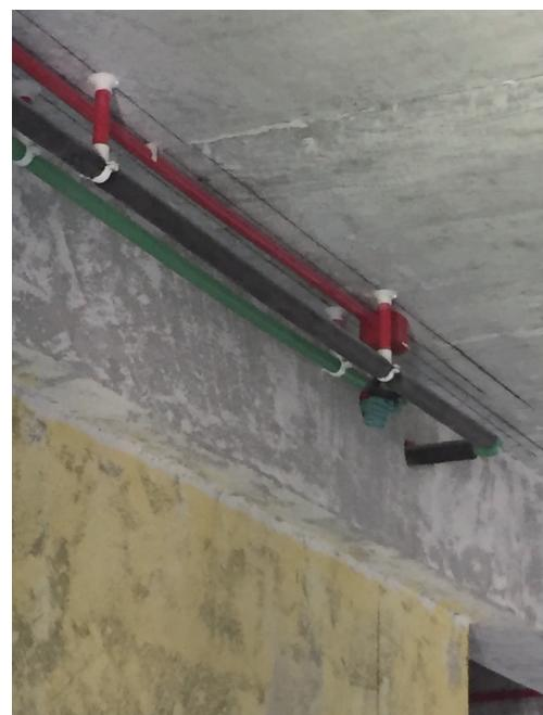
图 2-7 给水管顶面安装固定
