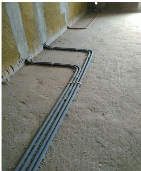
图 2-15 强弱电线管固定安装
