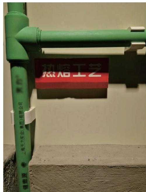
图 2-5 给水管管件热熔
