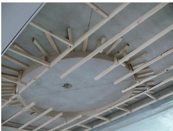
图 2-69 曲型天棚吊顶骨架安装
