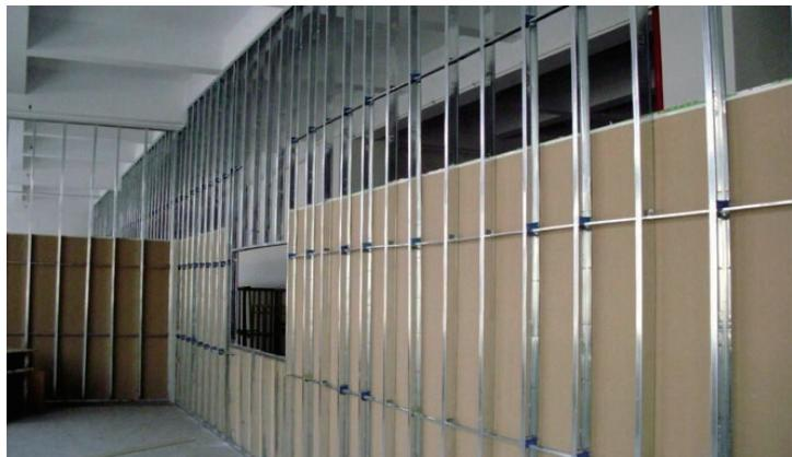
图 2-73 轻钢龙骨双面隔断骨架安装
