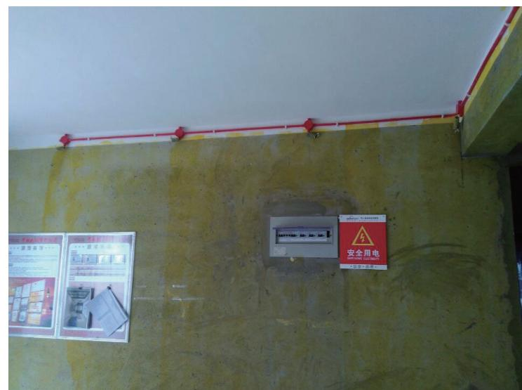
图2-14 强电线管顶面安装
