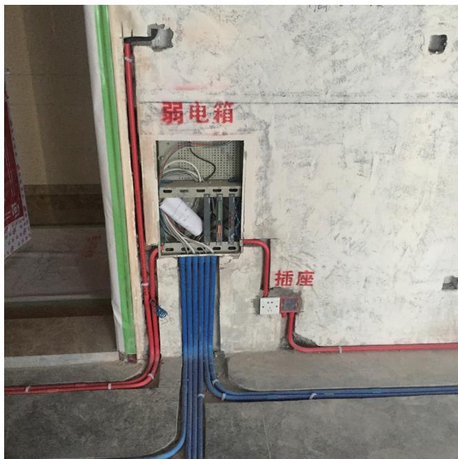
图2-11 弱电总箱定位、画线、切割、挖洞、埋设
