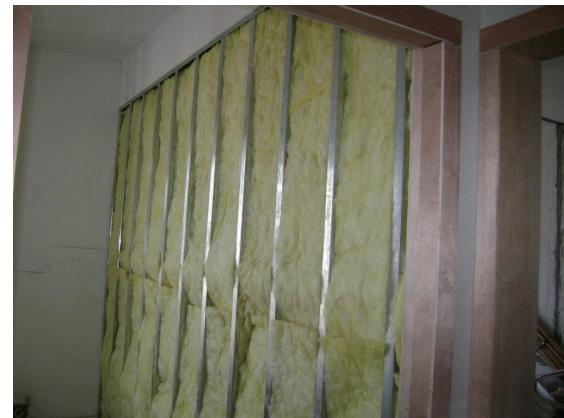
图 2-75 在隔断内部放吸声材料
