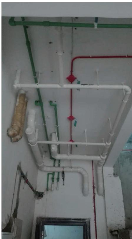
图 2-10 排水管黏结、安装固定
