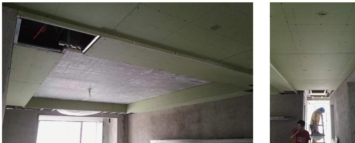
图 2-66 石膏板面层铺设安装
