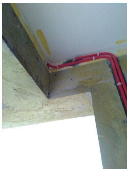
图2-13 强电线管过弯处理
