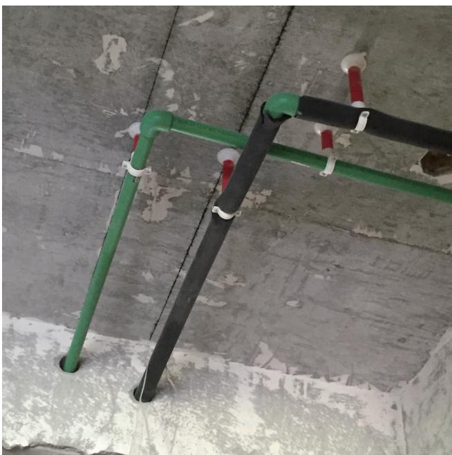
图 2-4 给水管吊卡安装
