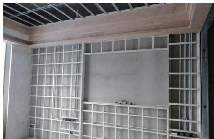
图 2-72 木龙骨单面隔断骨架安装
