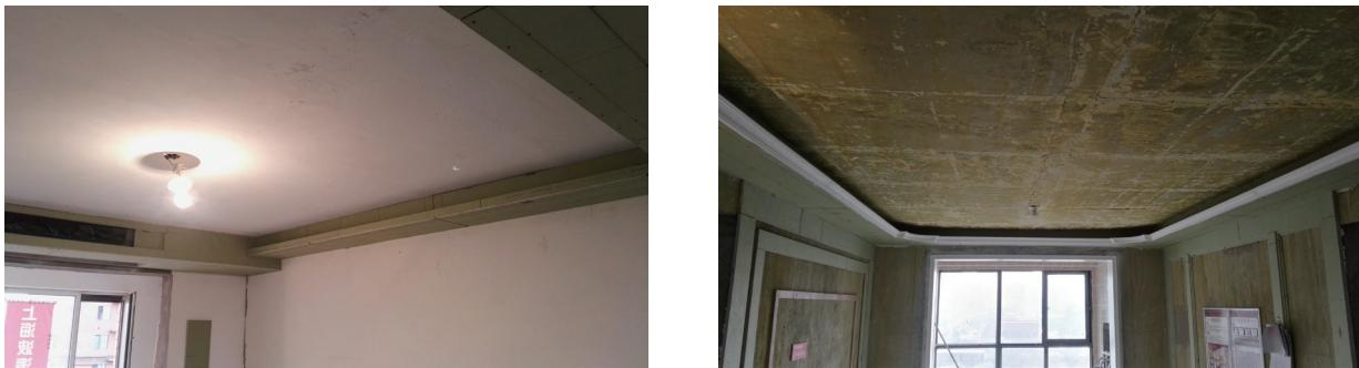
图 2-68 阶梯式天棚吊顶面板安装
