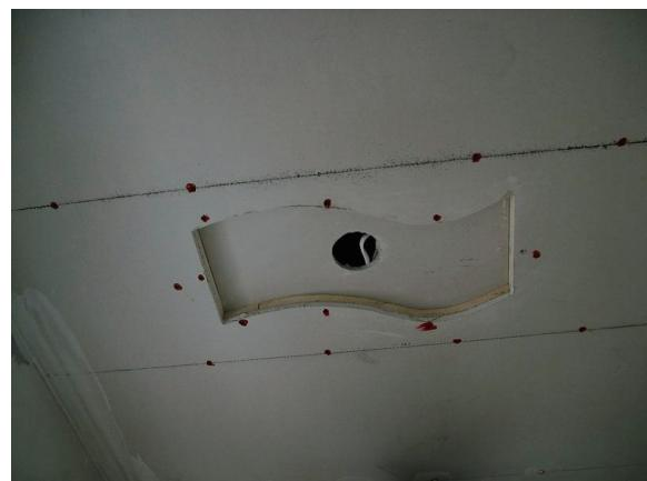
图 2-70 曲型天棚石膏板吊顶安装
