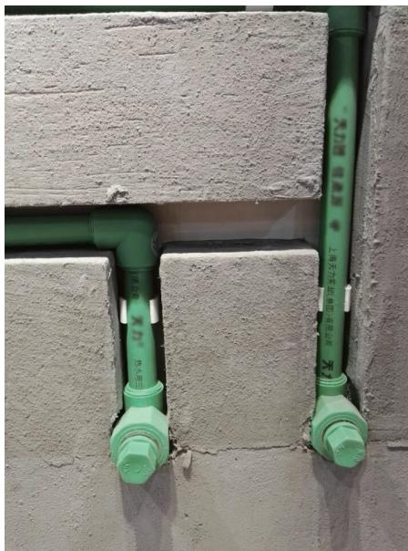
图 2-8 给水管回路安装固定
