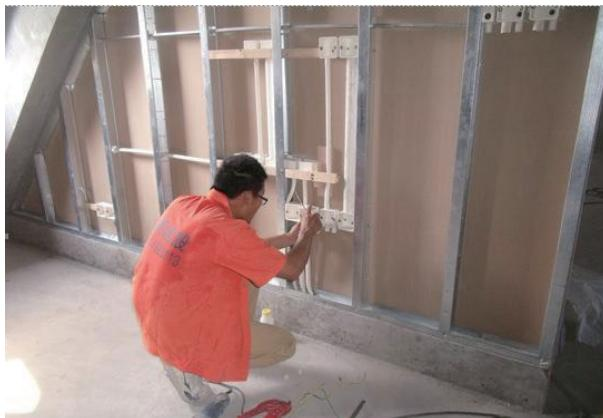
图 2-74 隔断内部线管检查
