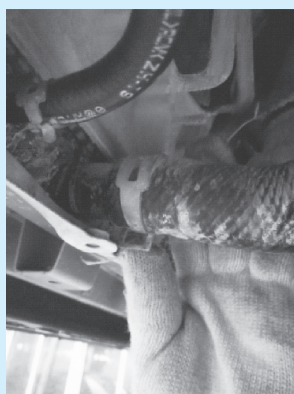
图 3-13 软管连接卡箍检查
