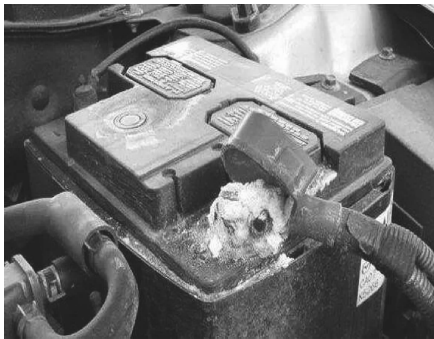
图 2-4 蓄电池桩头腐蚀
