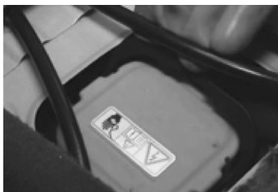
(b) 拆下维修开关
