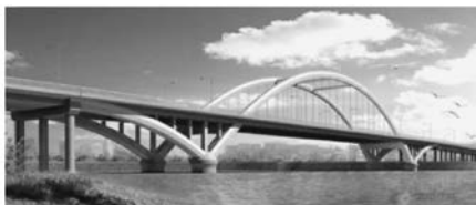
(b) 桥梁建筑
